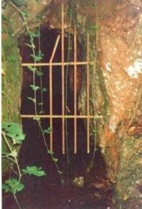
Stollenmundloch (1100m langer Talstollen)
